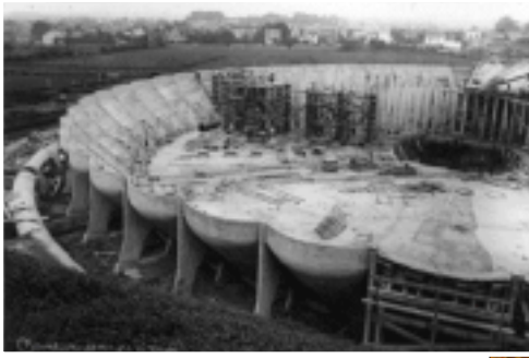
Construction de l'un des réservoirs dans les années 30.
