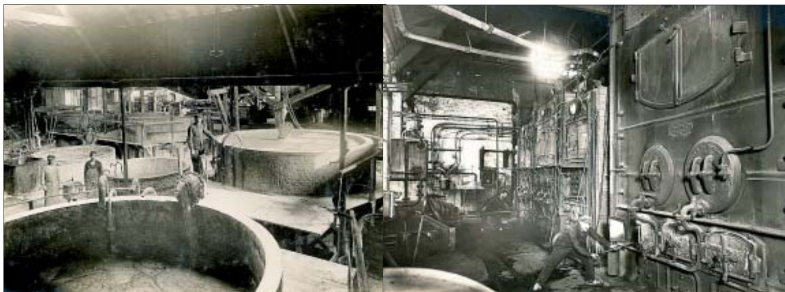
Vues générales de la salle des chaudières (à gauche) et de la salle des chaudières des établissements Biette vers 1930.
